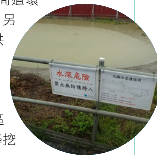
設置臨時沉砂池
