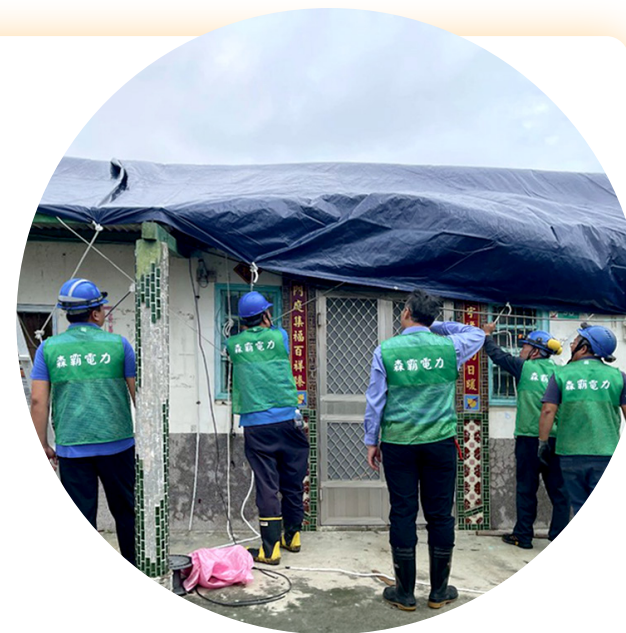
協助臺南地區丹娜絲風災受災戶屋頂修復工程
