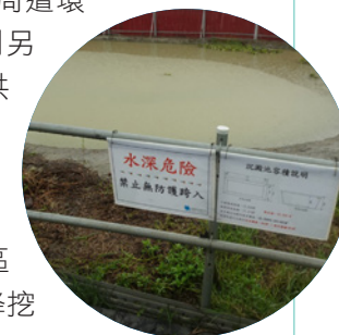
設置臨時沉砂池
