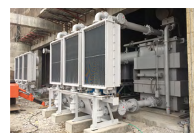
電氣室主變壓器安裝完成
