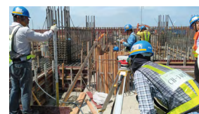
烈陽下進行電氣室施工
