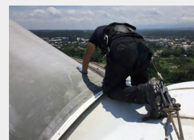
風機外部維護作業高空常遇強風十分危險困難
