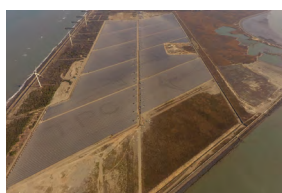
全國最大 100MW 台電彰濱太陽光電案場
