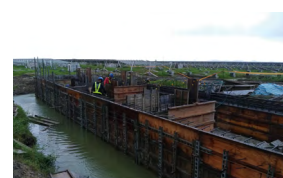
光電案場積水施工人員仍持續趕工
