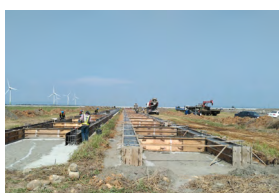
光電案場鑄型支架基礎施工
